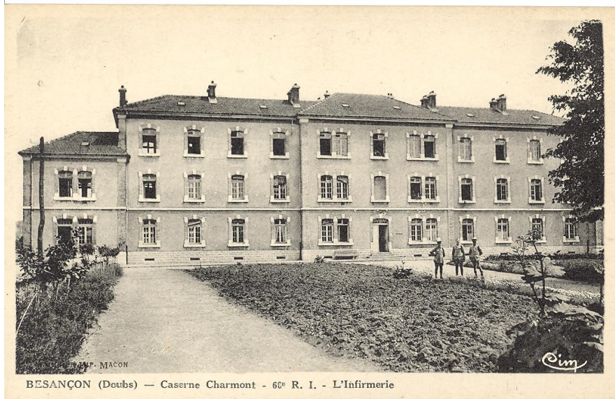
Bâtiment de l'infirmerie. (Sans date).
