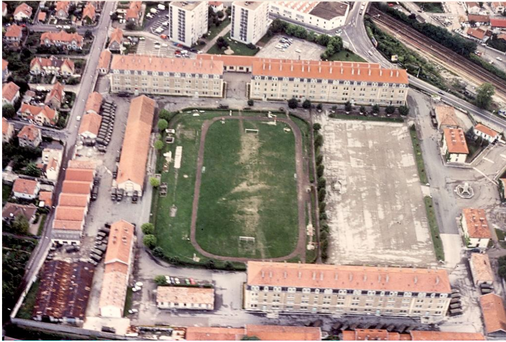
Vue aérienne de la caserne Vauban prise selon un axe sud-est/nord-ouest.
